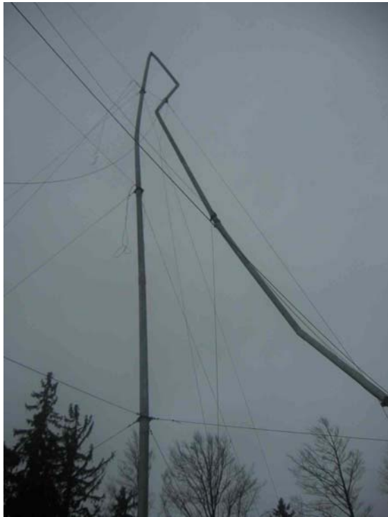
Abgeknickter Mast
