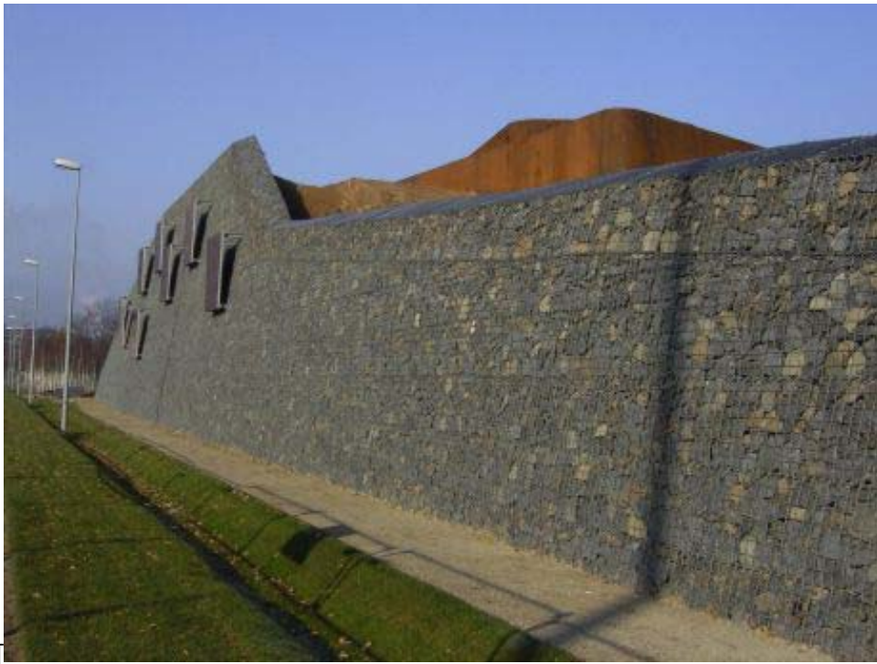
Fertiggestellte, sanierte Gabionenwand
